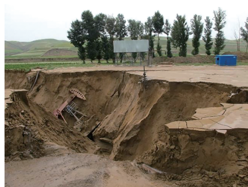
图2 延伸到井场的切沟
